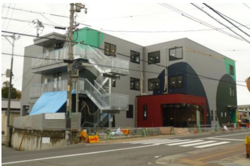
完成間近のサービス付き住宅。 29日、30日が内覧会です。
